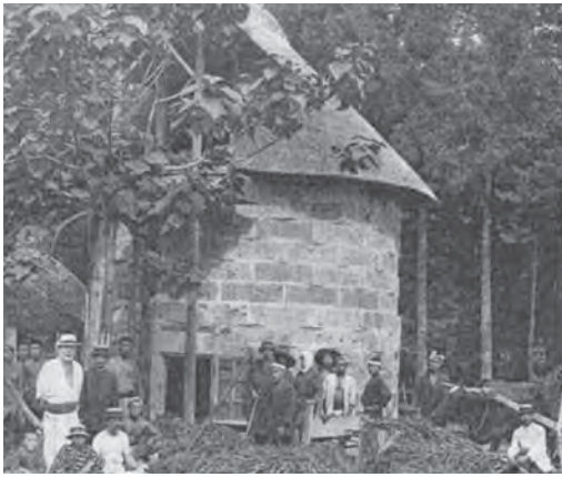
廣江嘉平が建設したサイロ。 地下8尺、地上13尺、内径15.5尺、容積3,912立方尺 （『廣江家の歴史』）
